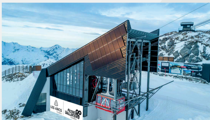
Gare de départ du téléphérique de l'Aiguille Rouge équipée de panneaux photovoltaïques l'année dernière
